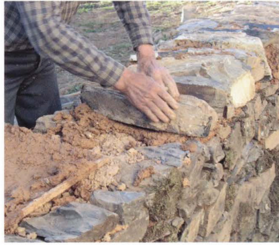
Requalificação do acesso ao poço em Cachopo: muro de alvenaria de xisto. (Gtaa Sotavento 2005)
